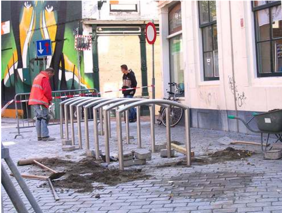
Монтаж нової велопарковки в центрі Брюсселя
